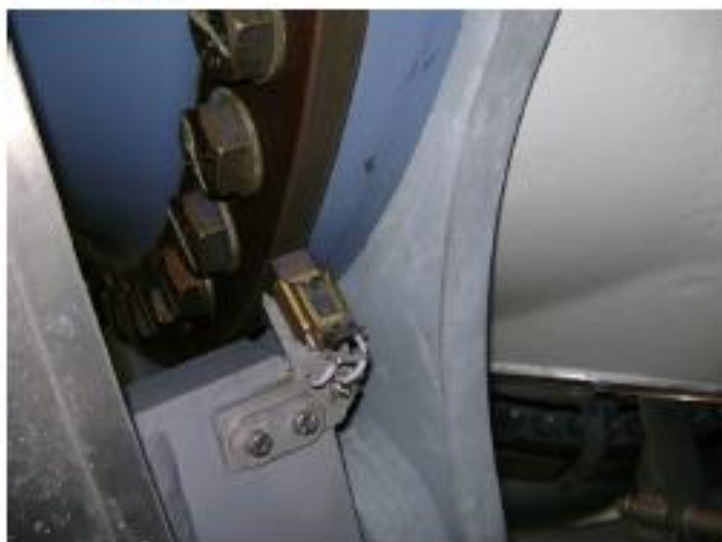
Fig. 3 : Balais de charbon avec éclateurs parallèles sur le disque d'arrêt du rotor
